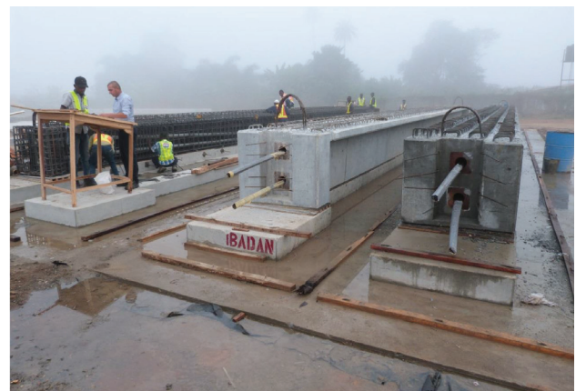
הקמת מפעל באתר הקבלן לטובת ייצור הקורות הטרומיות השונות
