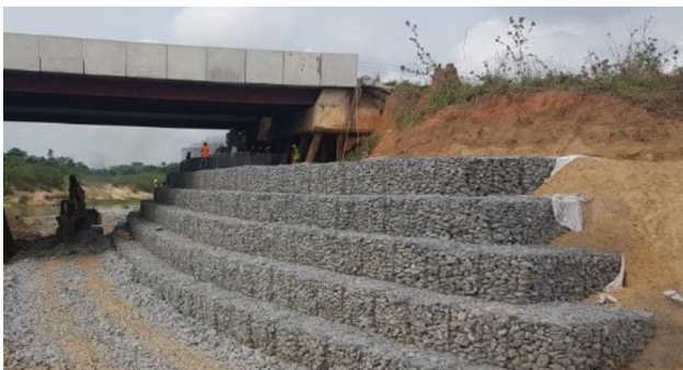
מימין - התחברות וחשיפת כלונסאות לפני שיקום, משמאל - סוללת נציב הקצה אחרי שיקום
