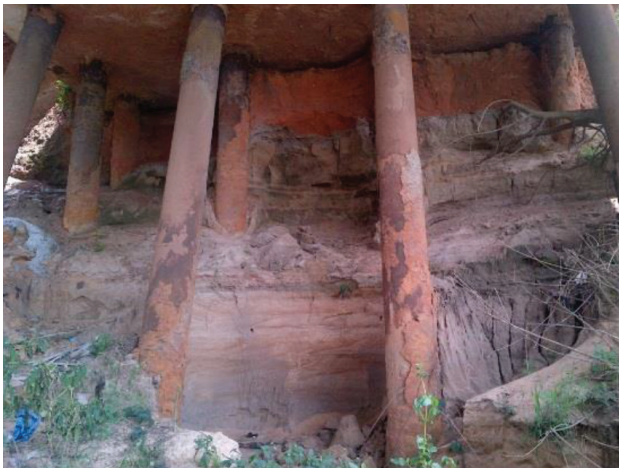
מימין - זרם מים סחף את סוללת נציב הקצה, משמאל - חשיפת כלונסאות נציב קצה ותחתית הנציב
