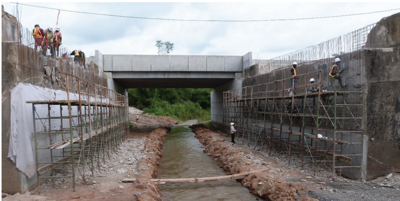
עבודות שיקום והחלפת מיסעה בגשרים תחתם התחוללה שריפה
