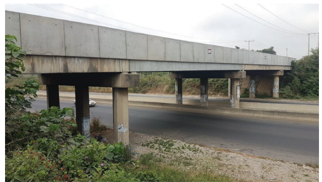
גשר מעל הכביש הראשי לאחר החלפת קורות והתקנת מעקות
