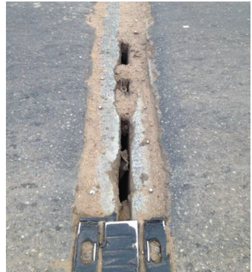
חימין - תפר התפשטות במצב קיים, משמאל - תפר התפשטות אחרי שיקום
