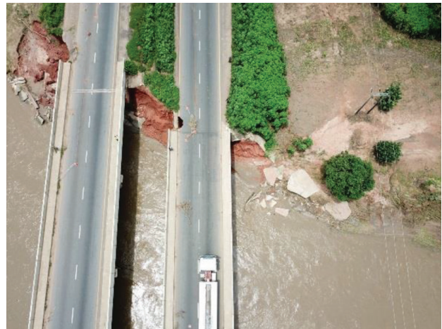
מימין - זרם מים סחף את סוללת נציב הקצה, משמאל - חשיפת כלונסאות נציב קצה ותחתית הנציב
