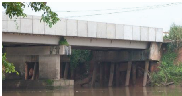
מימין - התחברות וחשיפת כלונסאות לפני שיקום, משמאל - סוללת נציב הקצה אחרי שיקום
