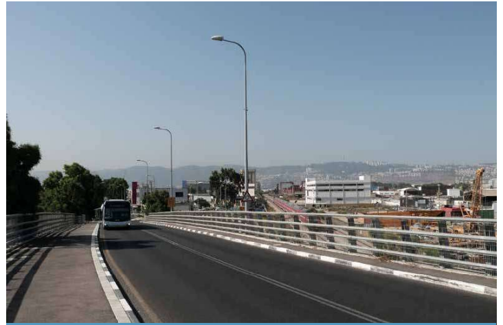
מבט אל מיסעת הגשר הכוללת נתיבי תנועה ומטרונית, שבילי אופניים ומדרכה (משמאל מטרונית על הגשר ומימין חוצה רכבת)
